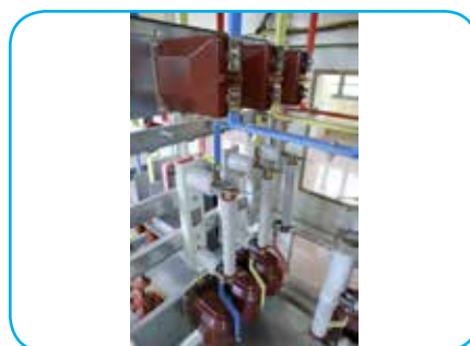
Máy biến điện áp
